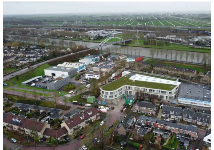
Het dak is over de gehele oppervlakte voorzien van sedumplanten.
